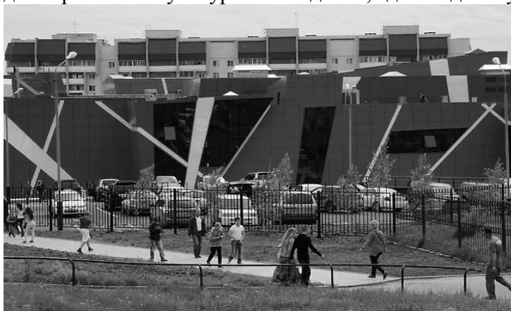
Кинотеатр «Хабаровск» после реконструкции
