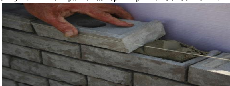
Рисунок 3 – Выполнение бесшовной кладки
