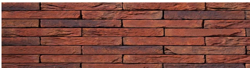
Рисунок 4 – Стена, выполненная по технологии бесшовной кладки
