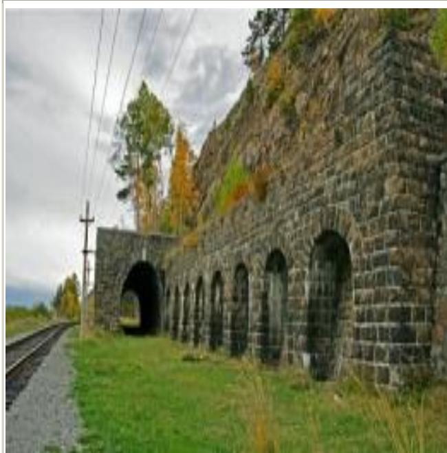
Подпорные береговые «итальянские» стенки. Единственные защитные береговые укрепления подобного оформления: грандиозная подпорно-одевающая стена многоярусной конструкции и заброшенное полотно с многочисленными подпорными стенками на мысе Киркерей. Такое название она получила из-за того, что ее арки очень напоминают итальянскую архитектуру. Проект стены разработывал итальянец Феррари. Неподалеку находится галерея № 7 «Большая Шумихинская». Ее построили для того, чтобы защитить дорогу от камнепада.
